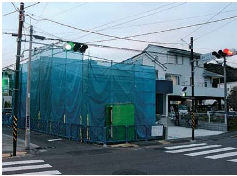
腰越に建設中の保育施設＝4月開所予定
